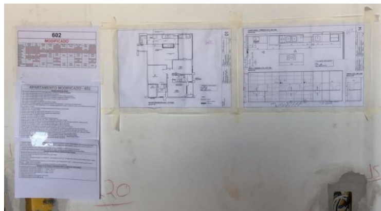
Figura 2 - Projetos e especificações referentes à paginação de pisos e paredes expostos na unidade a ser executada.
