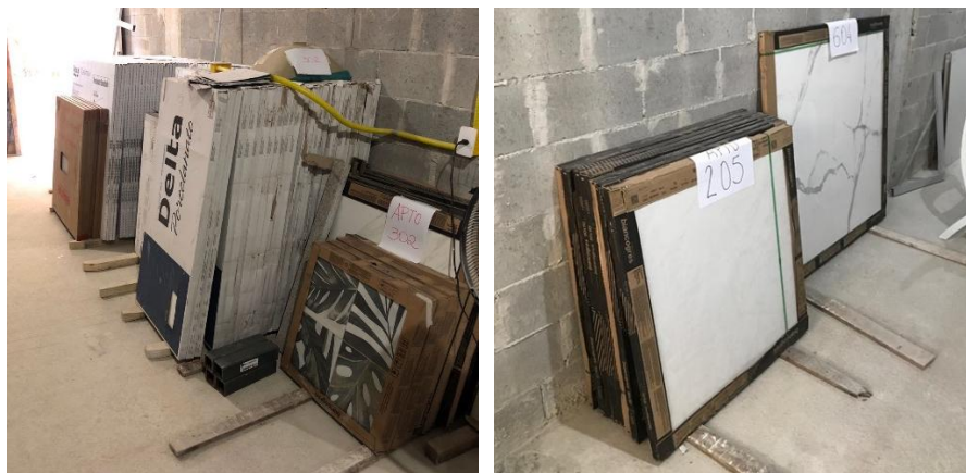
Figura 7 - a) Armazenamento de revestimentos cerâmicos na parede do escritório administrativo do canteiro; b) Identificação de revestimentos de apartamentos modificados.
