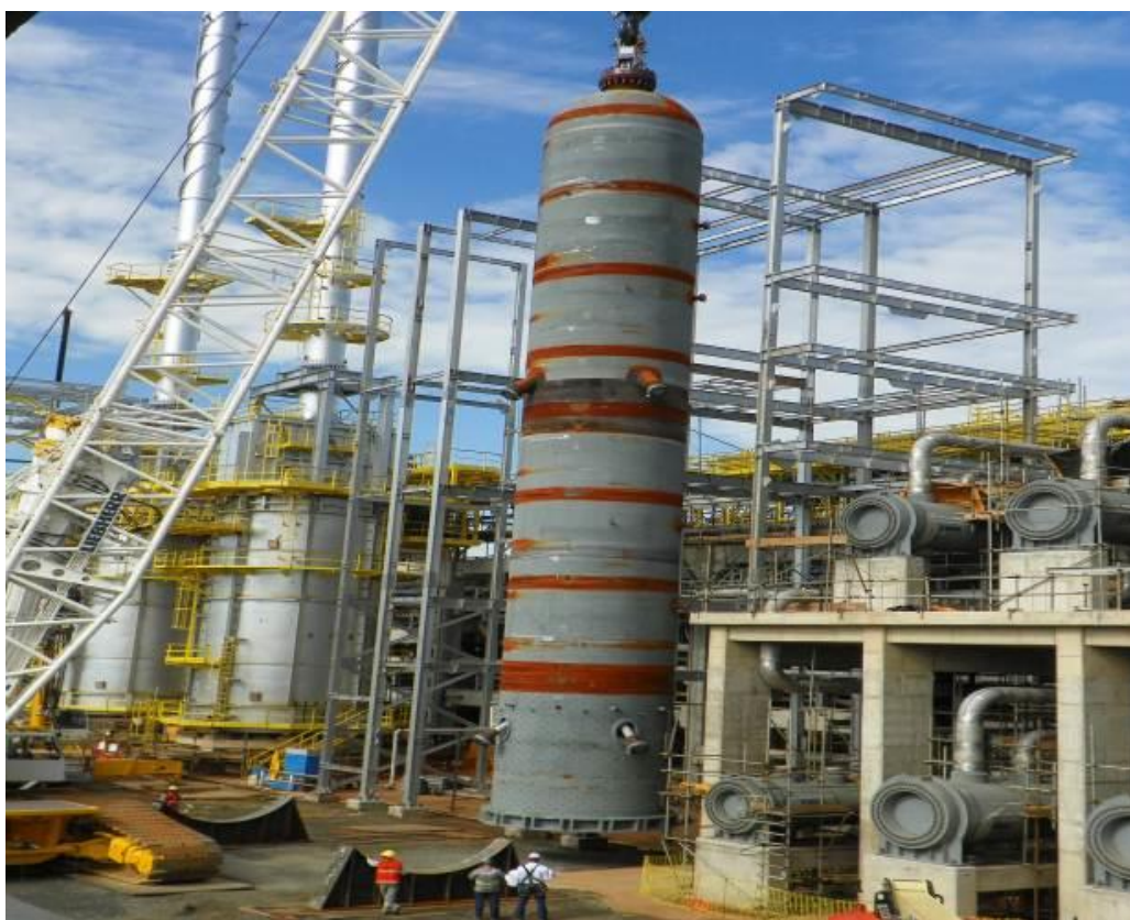
Figura 1- “Rigging” de reator de hidrotreatamento em refinaria petroquímica da Petrobras
