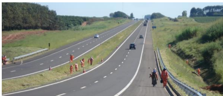
Figura 3 - Equipe de trabalhadores exercendo a sua atividade na rodovia. Fonte: Elaborada pelo autor.
